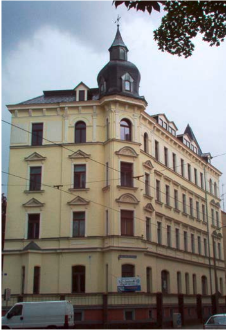
Abb. 24: Früheres Reclam-Wohn- und Geschäftshaus in der Marbachstraße
